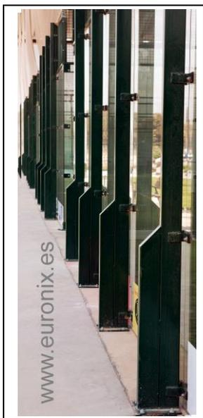
La estructura principal de la pista será metálica, a base de acero laminado en caliente de calidad S-275-JR y S-235-JR, mediante perfiles de 100x60x2 y 60x60x2 mm.
