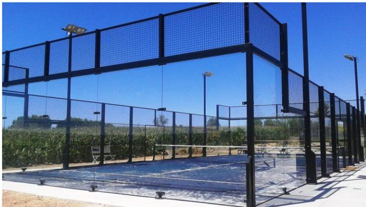
El sistema estructural estará formado por 18 pilares, cada uno de ellos descansando en su respectiva placa de anclaje y cartabones de refuerzo en su base.
